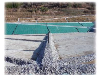
浸出水を集めて浸出水処理施設へ送ります。
