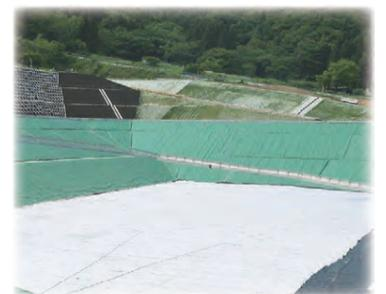
二重の遮水シートや漏水検知システムにより、浸出水の埋立地外への流出を防止します。
