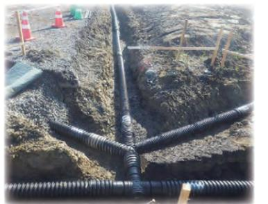
遮水工の下に設置した地下水集排水管により、地下水を安全に集めて下流河川に流します。
