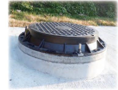
地下水の流向に沿って処分場の上流側、下流側に設置し、分析用水を採水する設備です。
