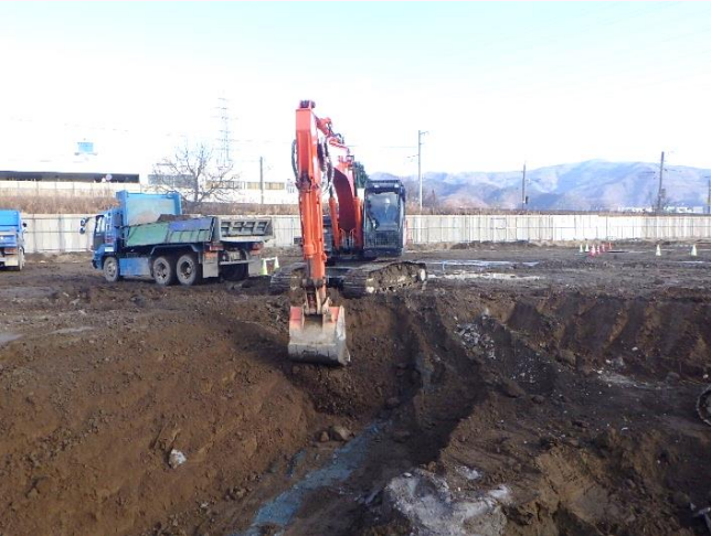
[山留工事を施工した箇所に沿って、地面を掘り進めていきます]
