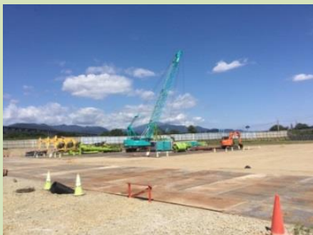
山留工事の様子
