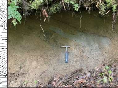
[P9] 下流斜面脚部の洗堀部はやや凝灰質な砂岩が露出、塊状で層理不明瞭、ハンマーのピックが何と刺さる程度の硬さ
