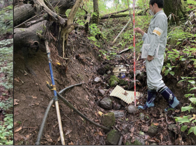
[P11] 中間崩壊谷地形の出口より数十m上流箇所、明瞭な流水ないものの取水施設跡あり、周辺に人工的な平坦部(耕作地跡)あり
