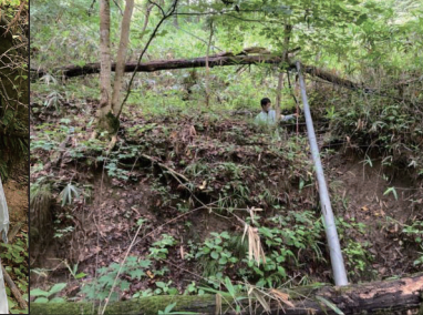
[P12] 中間崩壊谷地形の出口より数十m上流箇所、ガリー洗堀がみられ降雨時や融雪期には湧水があるものと想定される
