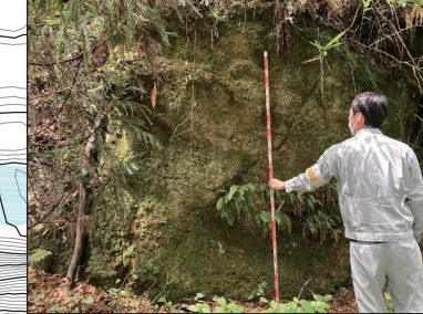
[P7] 下流側の崩壊谷出口部に認められる礫岩、塊状で層理不明瞭
