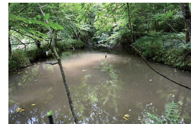
[P 07] 斜面上部にはため池が確認された。ため池の周囲には、凹地となっており湿地となっている箇所が確認された。
