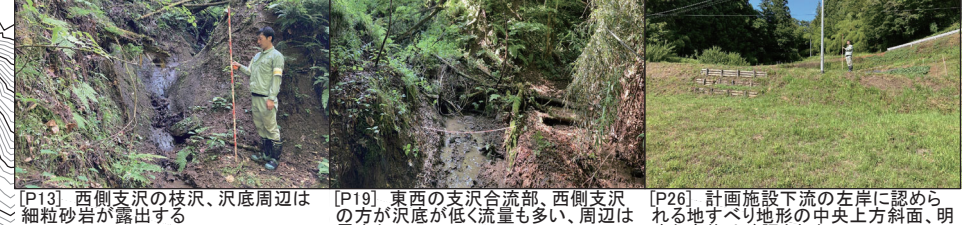
[P19] 東西の支沢合流部、西側支沢の方が沢底が低く流量も多い、周辺は露岩なし
