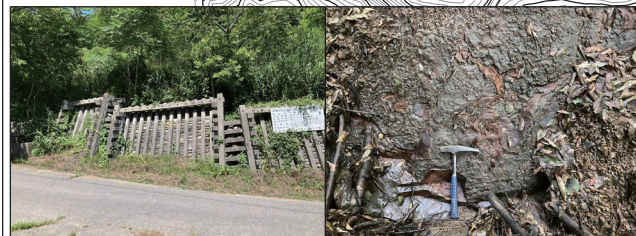
[P1] 道路脇に井桁擁壁および布団が設置される、湧水が多いことが想定される
