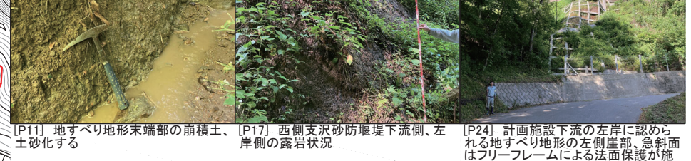
[P17] 西側支沢砂防堰堤下流側、左岸側の露岩状況
