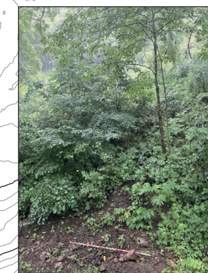
[P7] 急崖斜面の脚部、崖錐堆積物からの土砂流出あり
