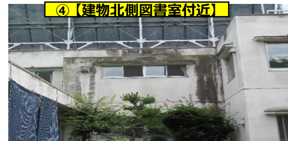
④【建物北側図書室付近】
