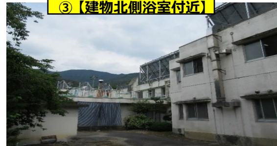
③【建物北側浴室付近】
