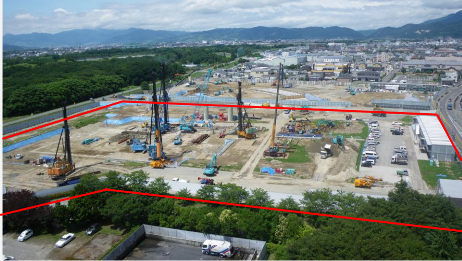
全景 赤枠：工事範囲
