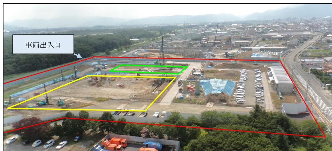
全景 赤枠：工事範囲 黄枠：工場棟建設範囲 緑枠：管理棟建設範囲
