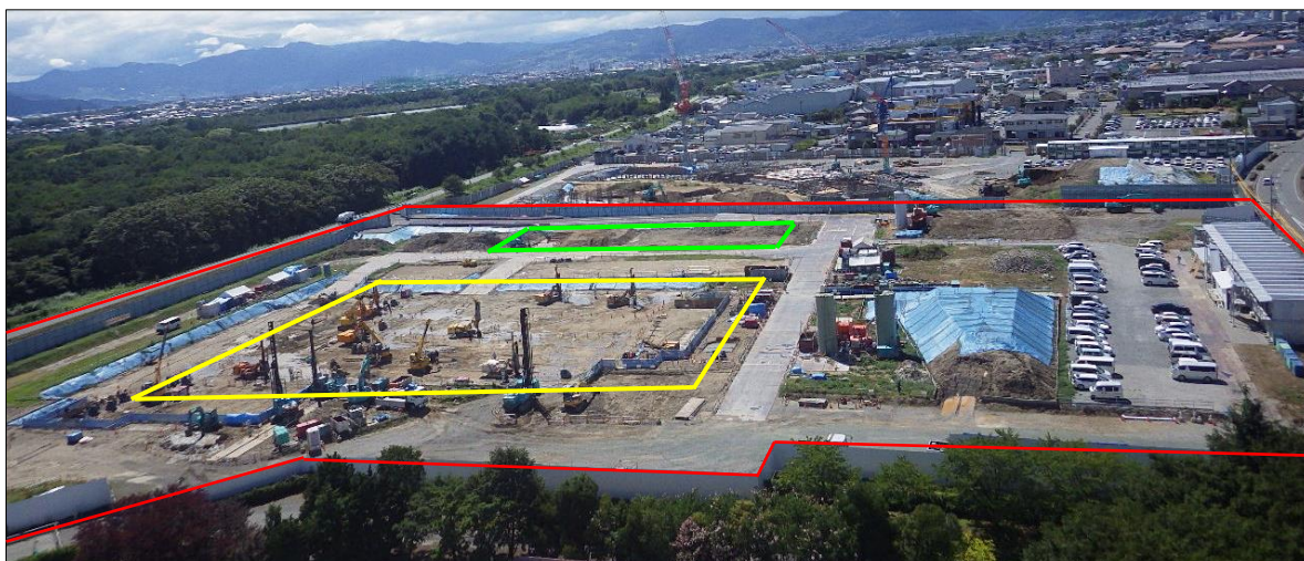
全景 赤枠：工事範囲 緑枠：管理棟建設範囲 黄枠：工場棟建設範囲
