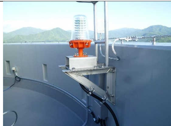
撮影⑥ 航空障害灯
