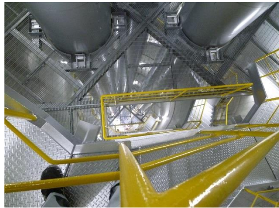
撮影④ 煙突内部
