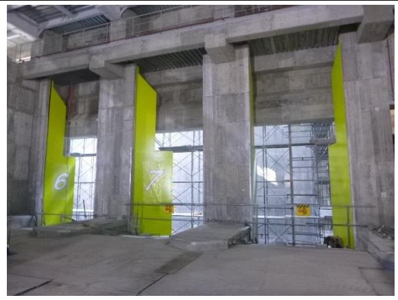
撮影④ ごみ投入扉
