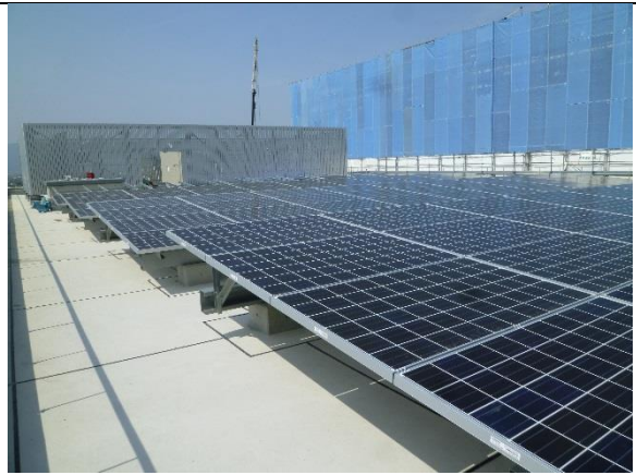
撮影③ 太陽光発電設備
