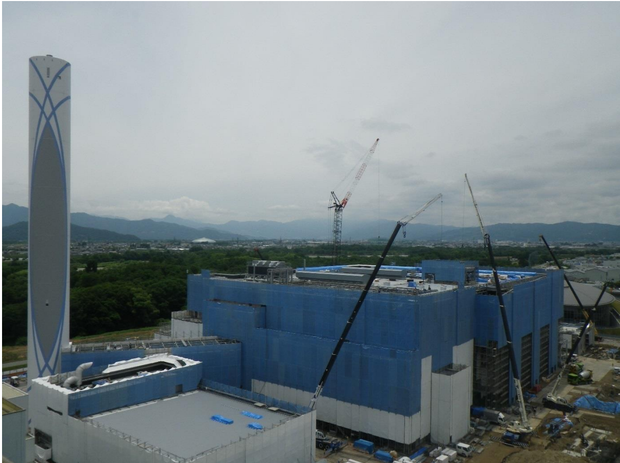
長野市清掃センター煙突から撮影
