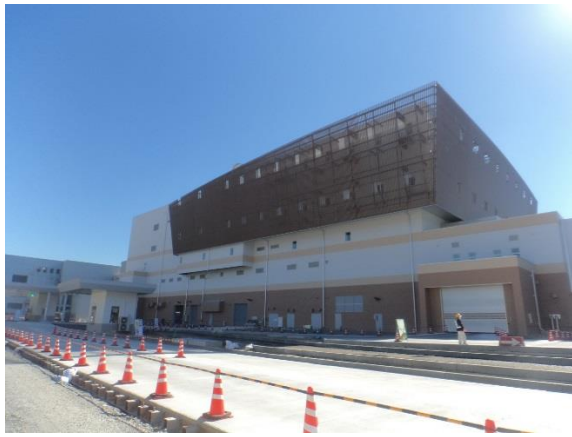
撮影② 外構（北側2）
