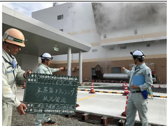
撮影⑥ 蒸気フラッシング
