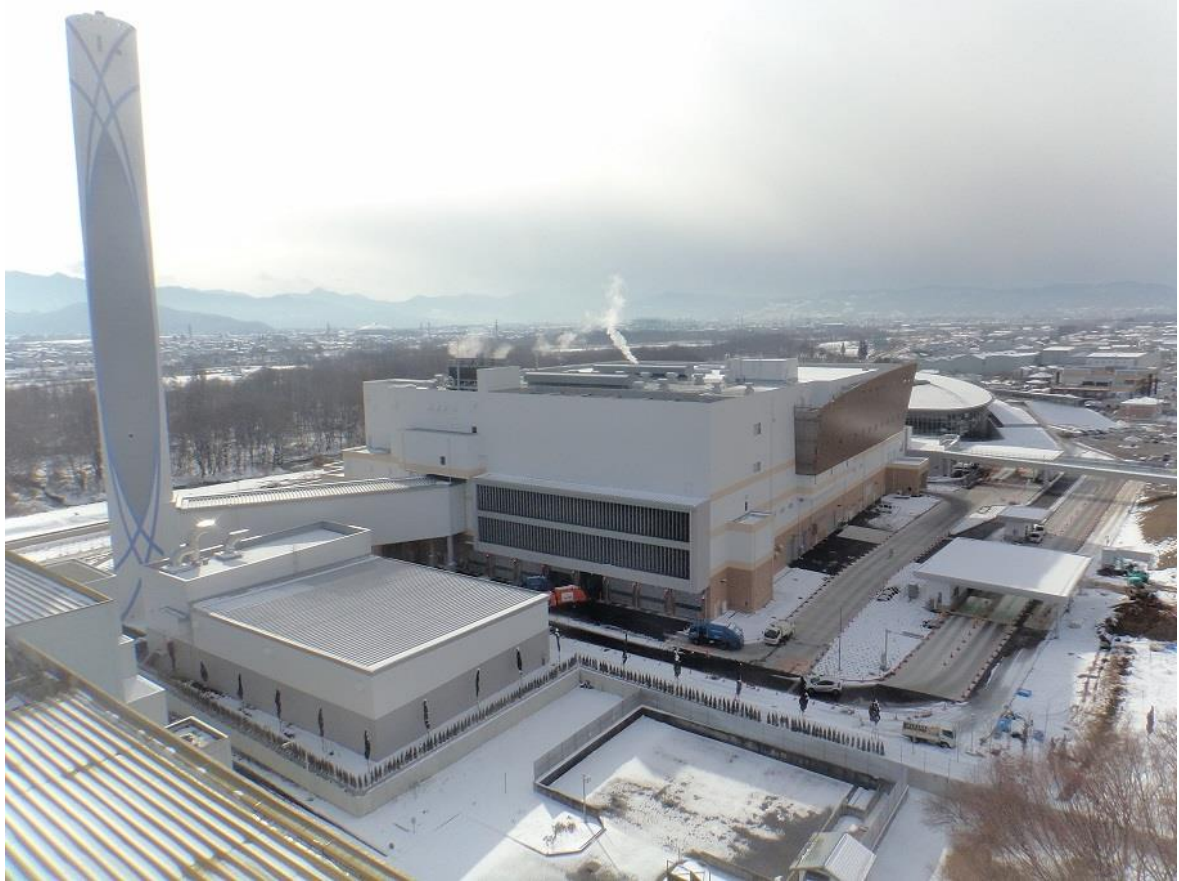
長野市清掃センター煙突から撮影
