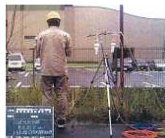
写真-3 (臭気の調査状況)
