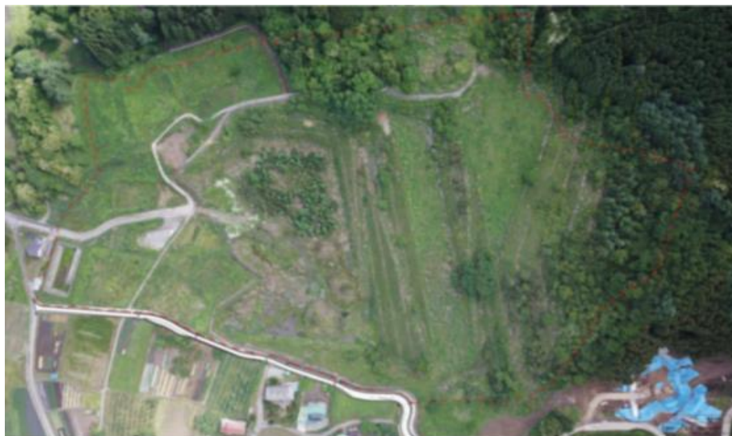
最終処分場全景写真
