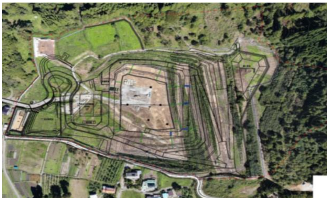
最終処分場全景写真
