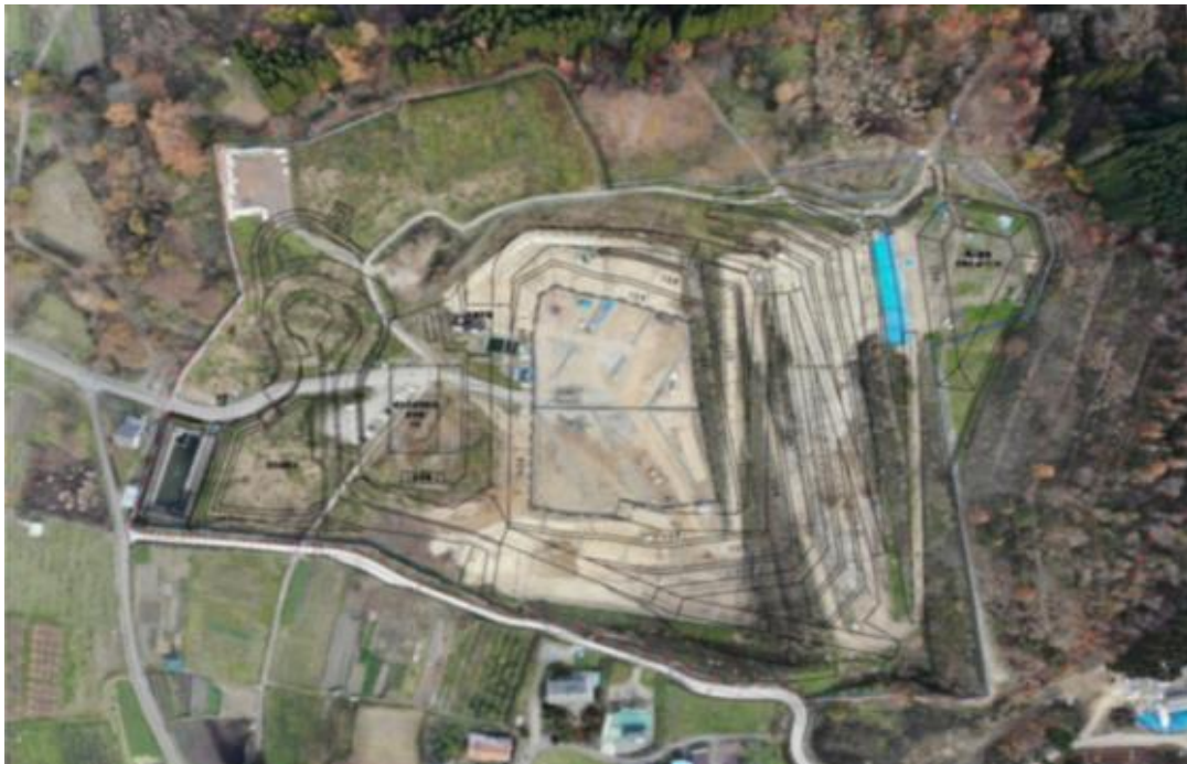
最終処分場全景写真
