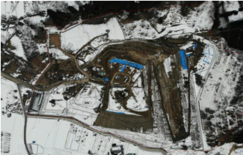
最終処分場全景写真
