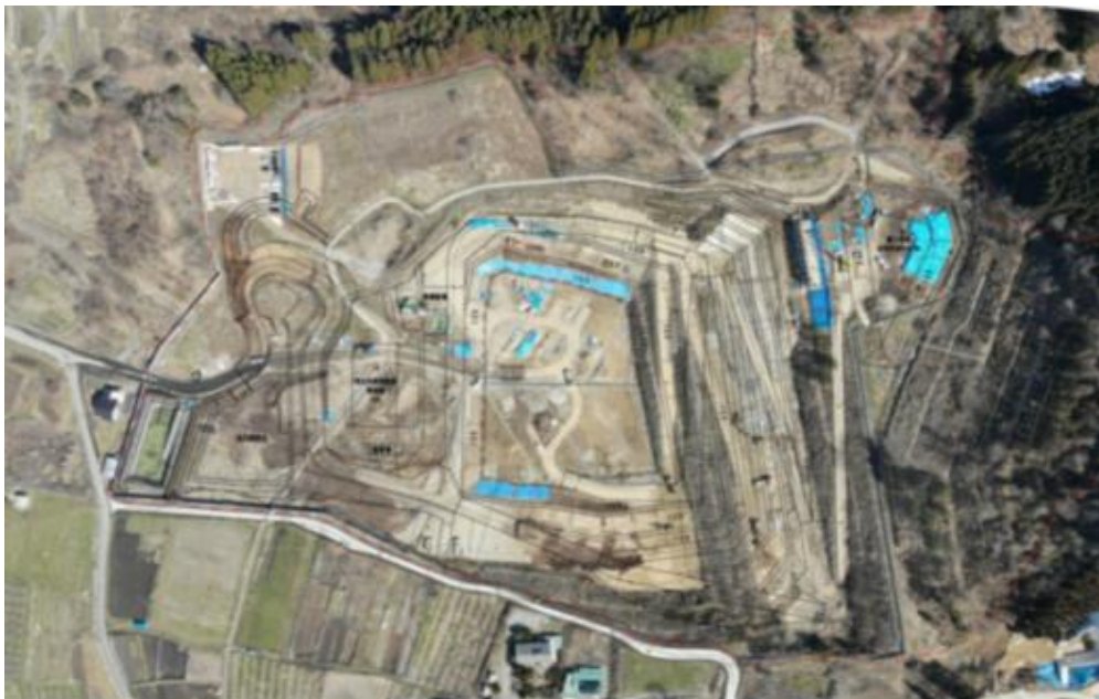
最終処分場全景写真
