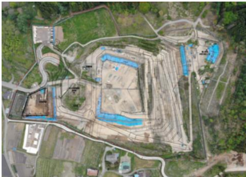
最終処分場全景写真
