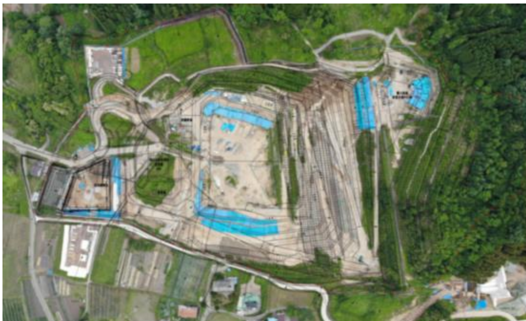
最終処分場全景写真
