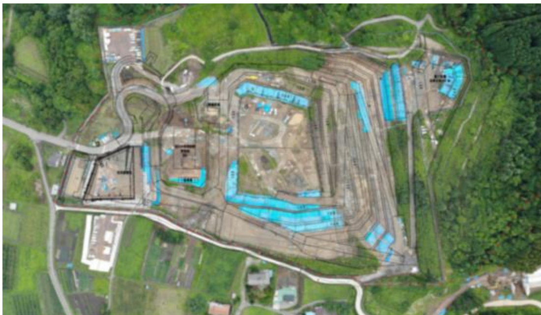
最終処分場全景写真
