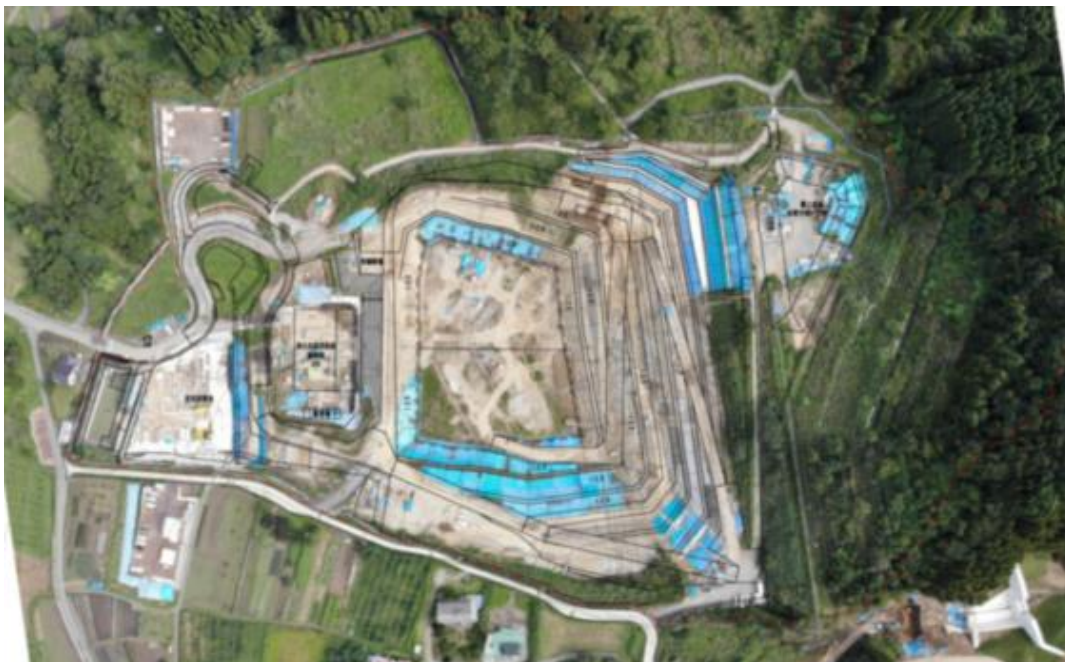
最終処分場全景写真
