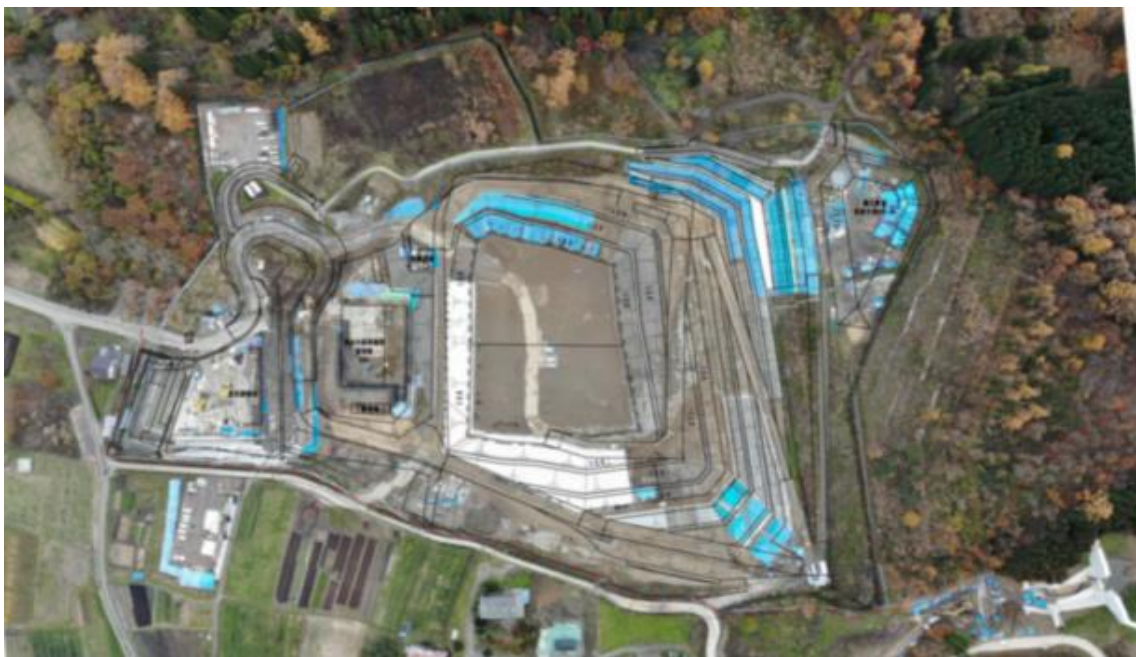
最終処分場全景写真
