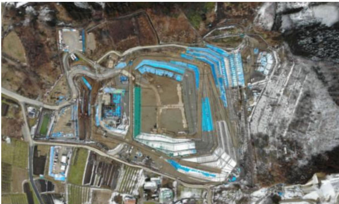
最終処分場全景写真
