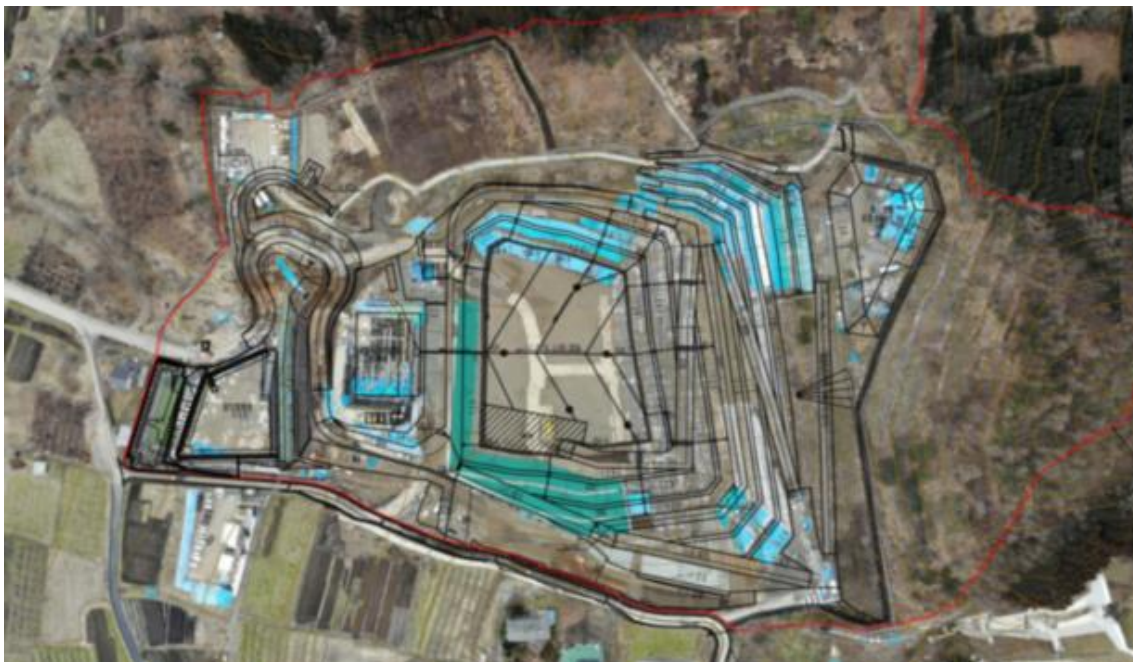
最終処分場全景写真
