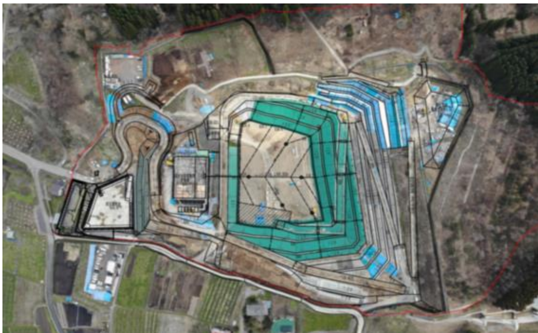
最終処分場全景写真
