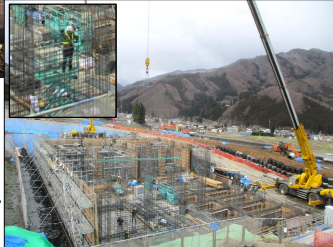
壁鉄筋吊り込み状況
