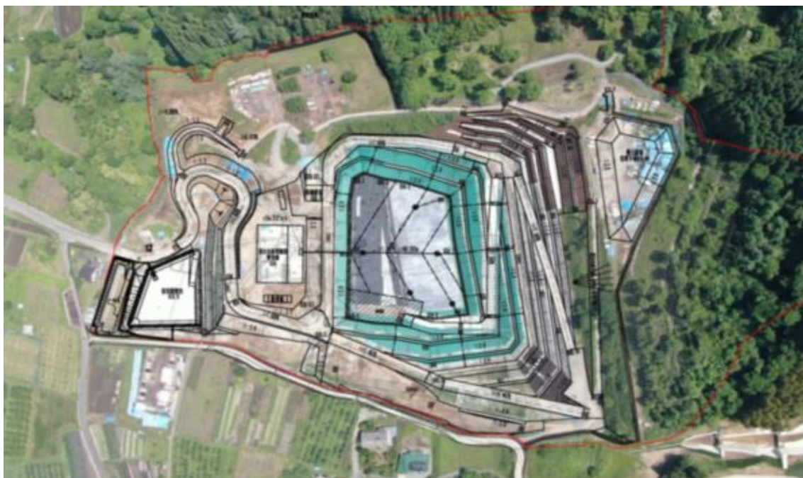
最終処分場全景写真
