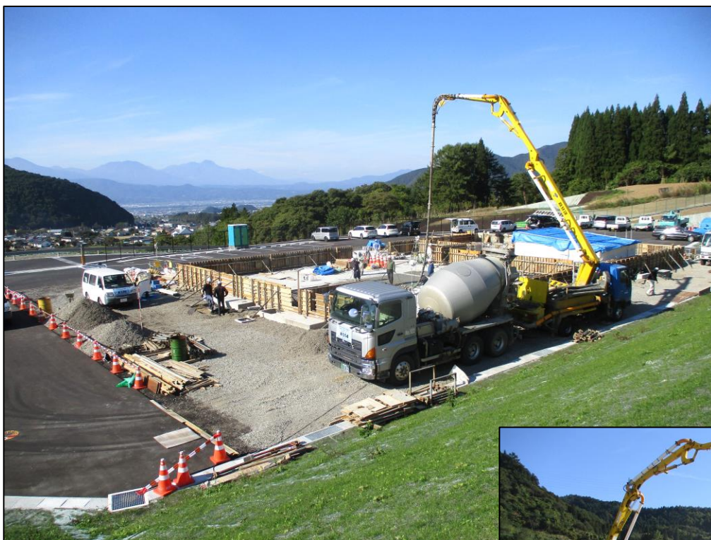
コンクリート打設状況
