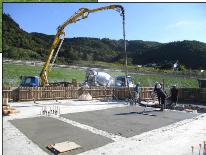
コンクリート打設状況
